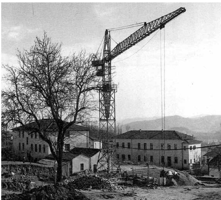
Un momento della costruzione della nuova sede del Circolo Giovanile.
